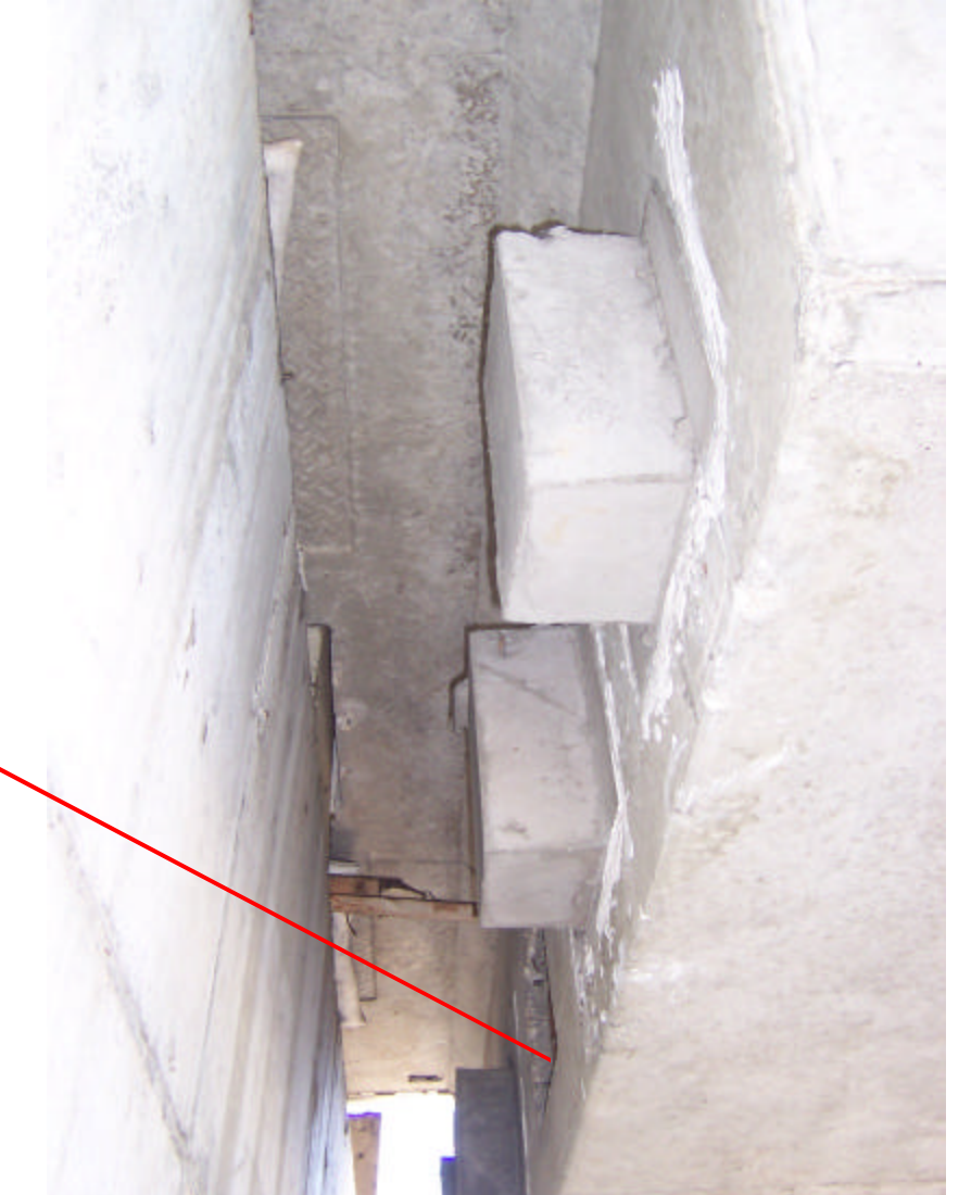
Figura 1: Punto de anclaje de los cables de post tensado descubierto
